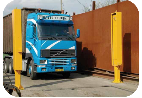
Şekil 1. Kapı - Panel tipi Radyasyon Tespit Sistemleri
