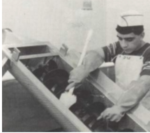
Şekil 3. Peynir üretiminde kullanılan Teflon kaplı ekstrüder vidasının temizleme işlemi (6)
