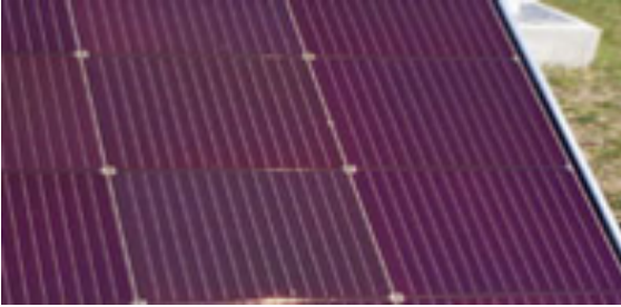
Şekil 6. Kadmiyum Tellür Fotovoltaik Hücre
